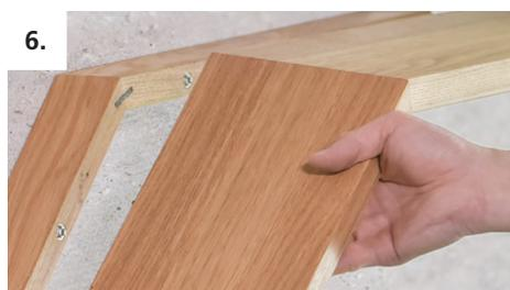
6. Ensamble el listón de montaje y la balda directamente en la pared
