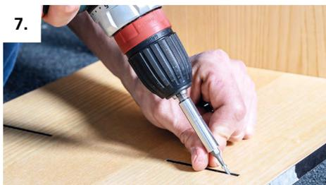
7. A continuación, fijar las mitades del elemento de ensamble con los tornillos suministrados. En caso de materiales quebradizos, pretaladrar los tornillos con una broca de 2 mm.
